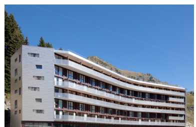
1 - La façade courbe du bâtiment
