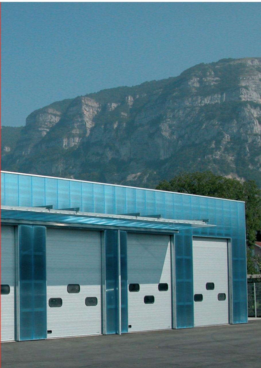
La halle technique est composée d'un volume parallélépipédique de 52 mètres par 14 organisé en travées régulières dont 7 s'ouvrent sur l'avant par de vastes portes sectionnelles.
